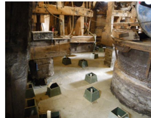
De vloer voordat er beton gestort zou worden...
