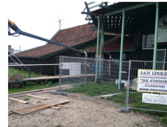
Foto linksboven: Jan Ijskes voor De Ooievaar. Foto rechtsboven en beide foto's onder: Funderings- werkzaamheden door De Coogh in De Bonte Hen.
