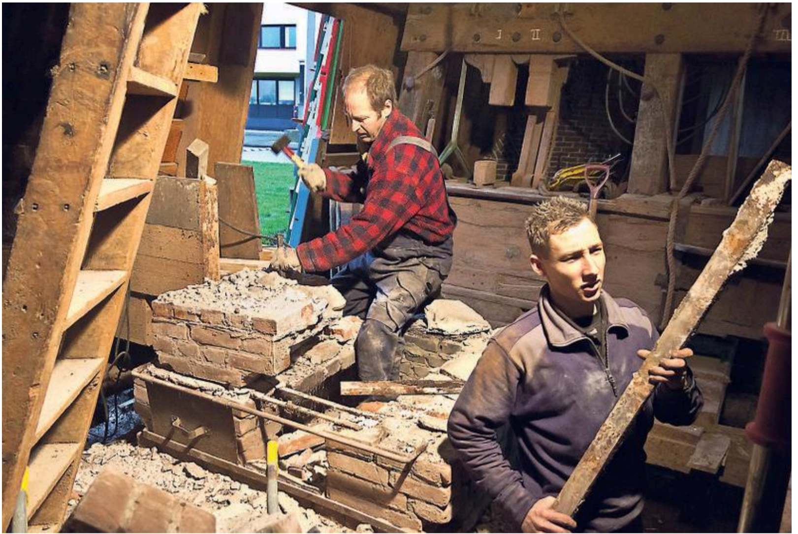
Fred Havik (l) sloopt het metselwerk, Remco Kramer ruimt op.
