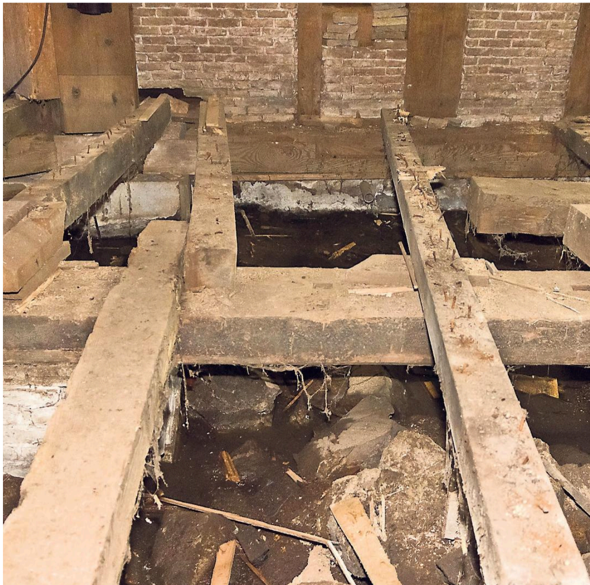
De vloer is er al uit.
